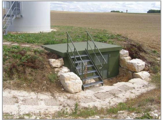
*Transformateur placé en contrebas de l'éolienne.*
